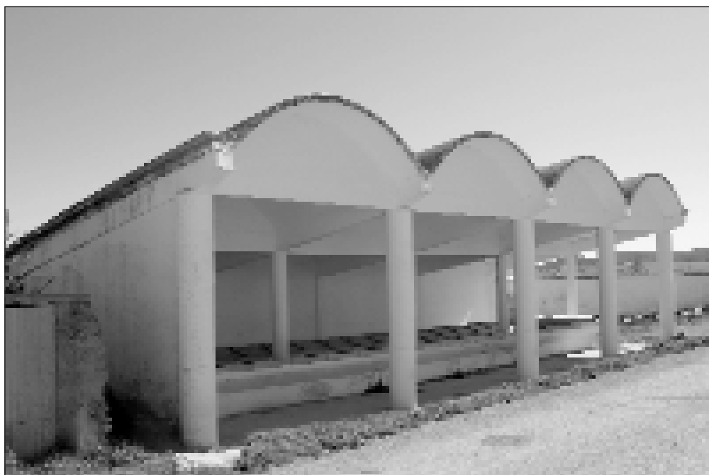
Lavadero de bóveda de Tornos.
