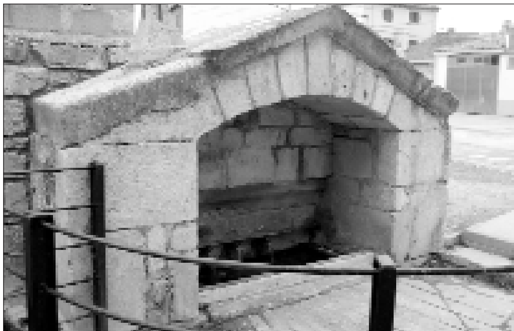
Fuente de Blancas, antes de la restauración.
