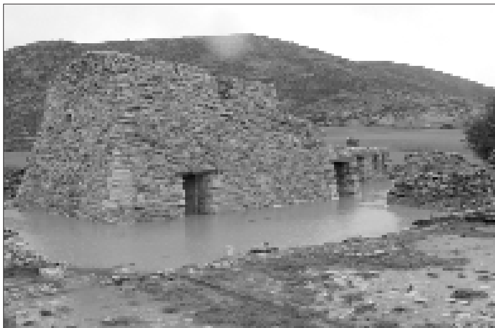
Vista del edificio del pozo durante las lluvias de la primavera de 2008
