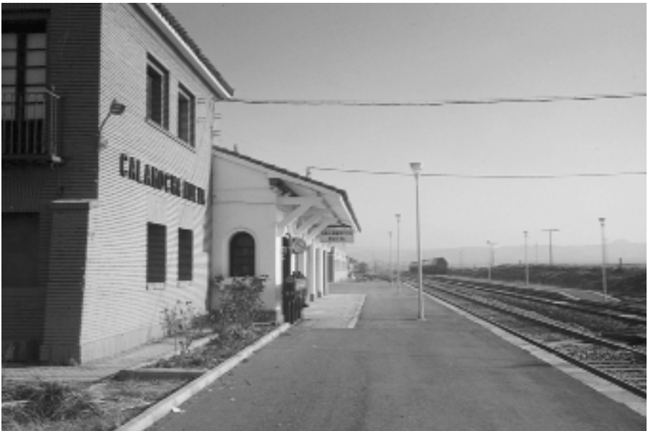
Estación de Calamocha-Nueva, una de las únicas abiertas al tráfico a efectos de circulación.
