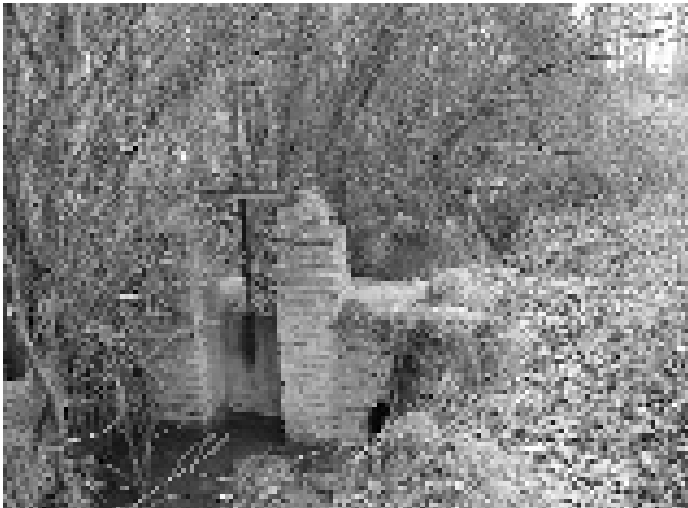
Imagen 3. Tajadera del canal Ojos-río extraída. En la parte derecha de la tajadera se puede observar que el agua pasa por una grieta de unos 10 cm. y ya no era funcional.
