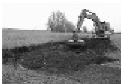
Imágenes 6 y 7. Balsa de laminación de avenidas durante la construcción y en fase de crecida del río.
