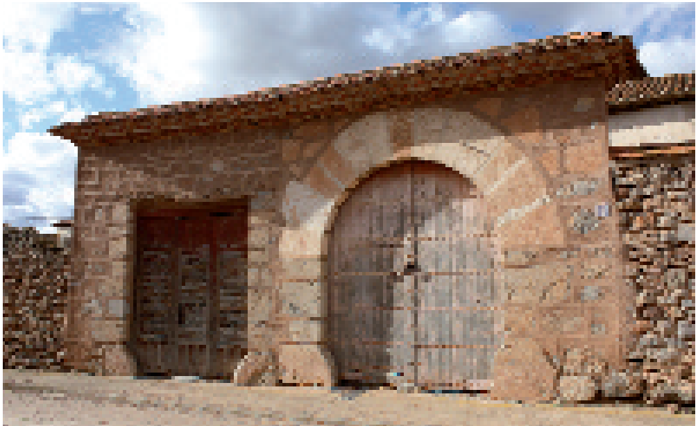
Puerta de acceso a la casa familiar de Lidón.
