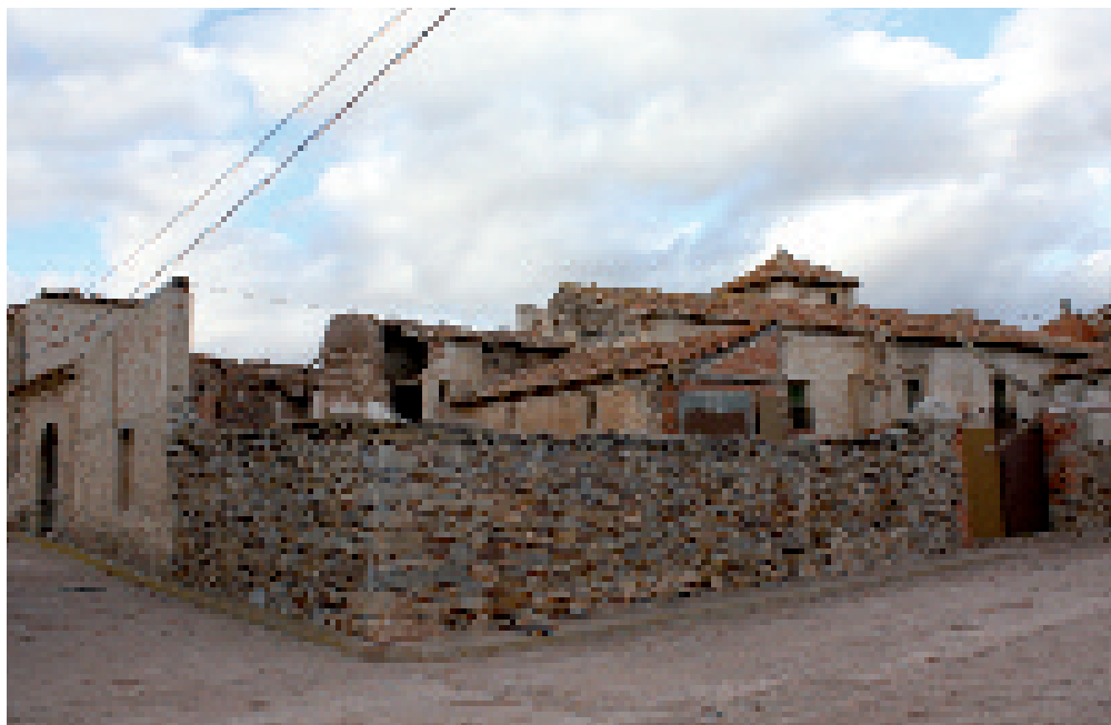
La vivienda de Lidón ocupa toda una manzana urbana.
