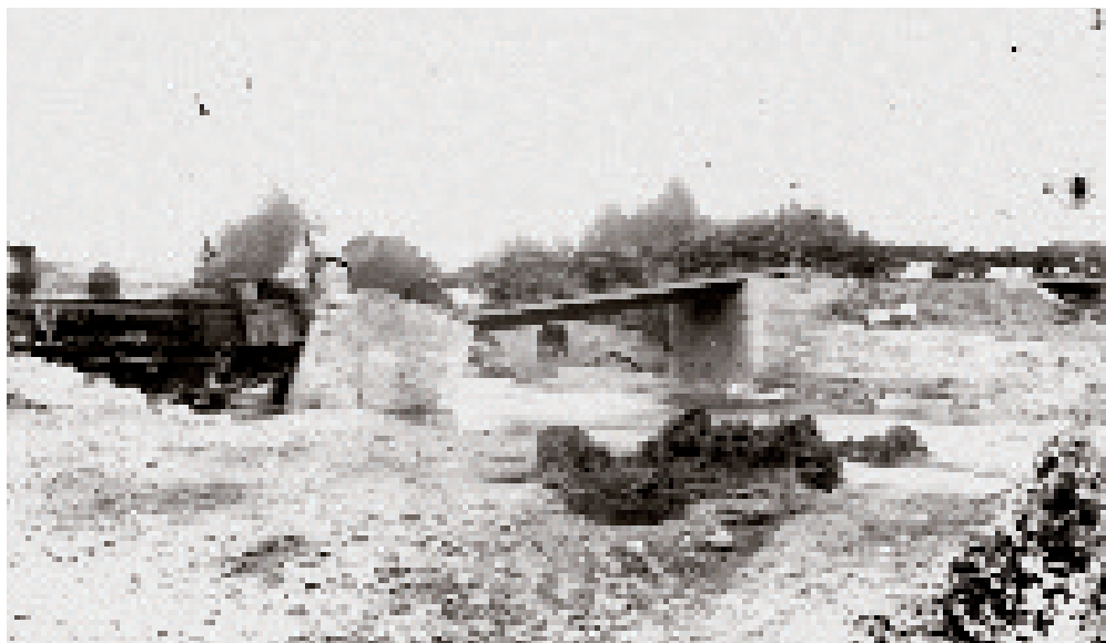
Hundimiento del puente del ferrocarril sobre el río Pancrudo en 1904. Luco de Jiloca. (Archivo: C.E.J.).
