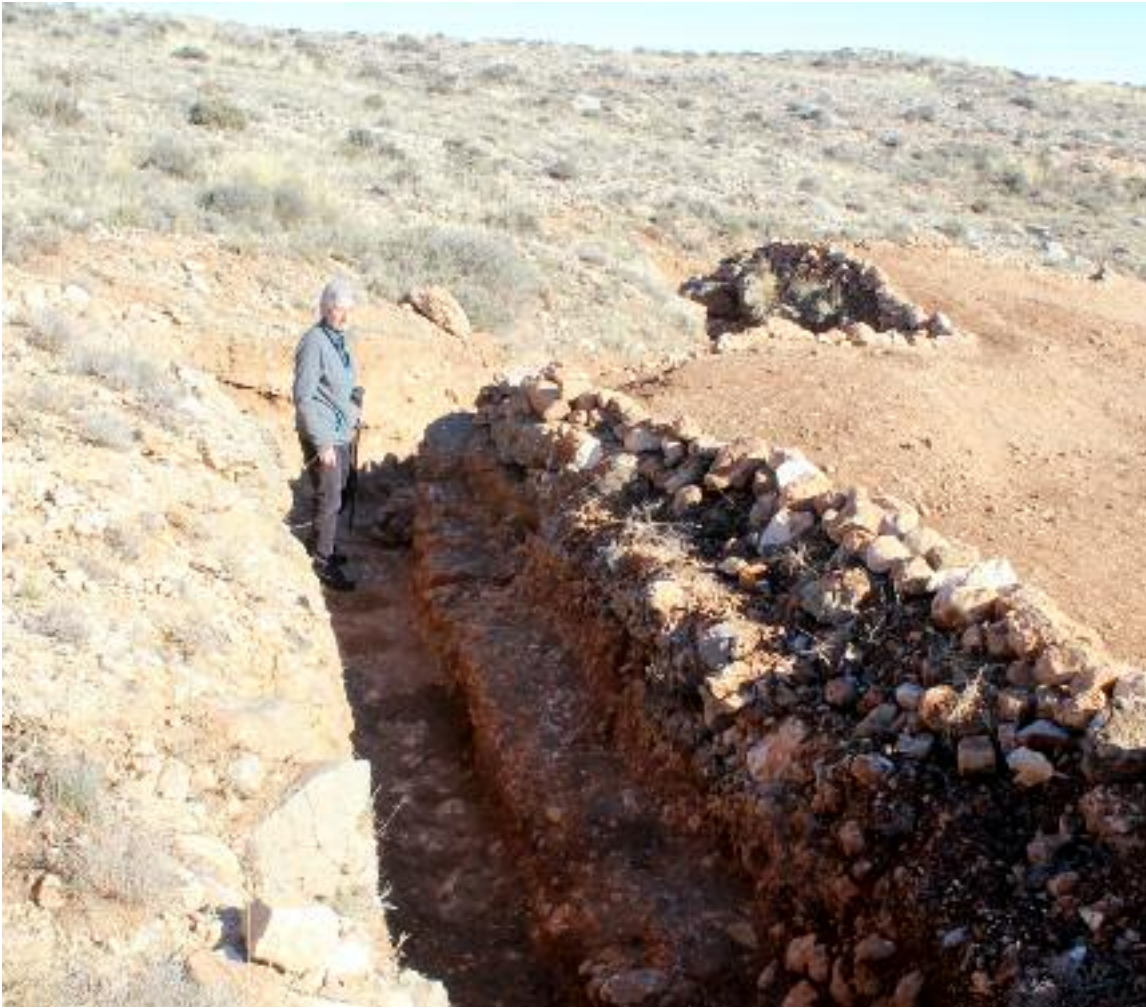
Panorámica de la ampliación de la trinchera en el Cabezo Santo de Monforte de Moyuela
