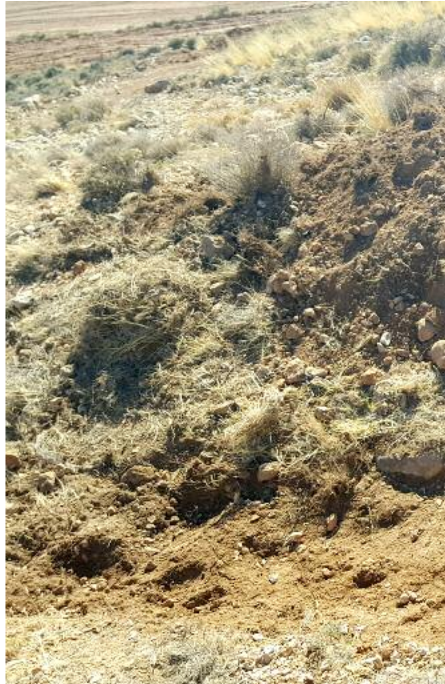
Trabajos de excavación realizados en la ampliación de la trinchera
