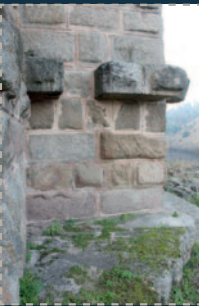
Detalles de la sillería almohadillada del puente romano de Alcántara (Cáceres).
