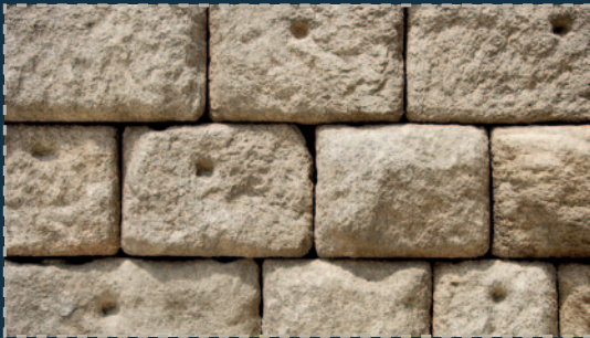
Sillería con agujeros de las pinzas de hierro en el acueducto de Segovia.
