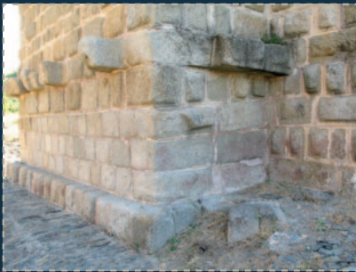
Detalles de la sillería almohadillada del puente romano de Alcántara (Cáceres).
