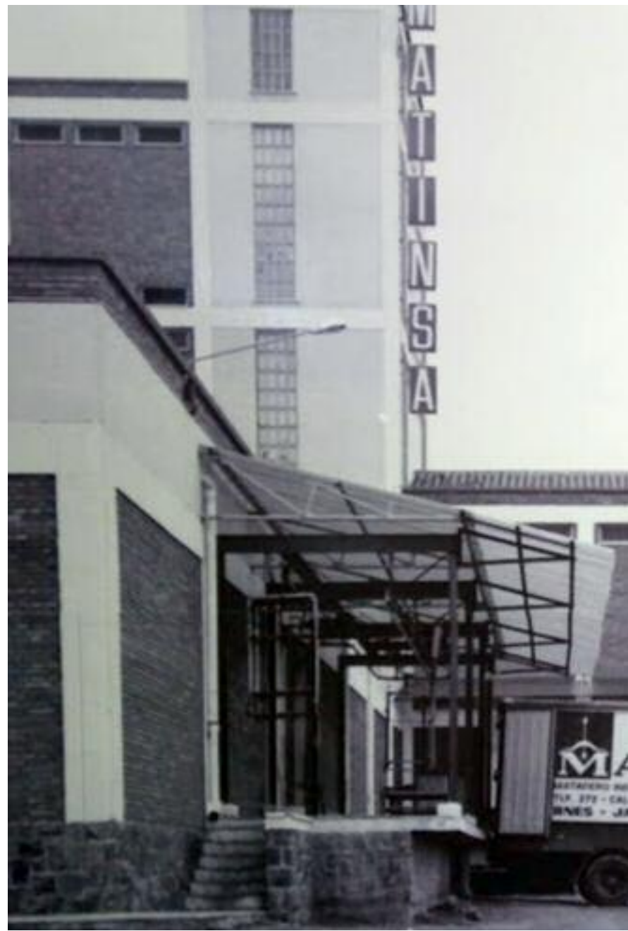
Muelles de carga del Matadero Frigorífico Industrial de Calamocha, Matinsa
